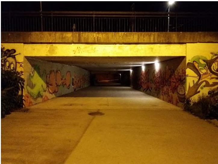
Obrázek 13: Kontrola podchodu u zastávky MHD Novolišeňská
