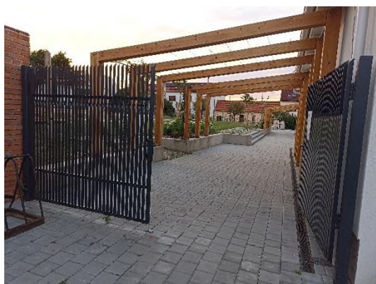
Obrázek 8: kontrola Dělnického domu
