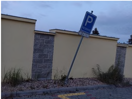
Obrázek 5: nakloněná dopravní značka na parkovišti u hřbitova
