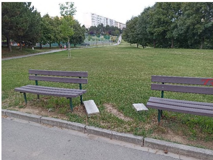
Obrázek 20: Nevhodně pohozené betonové kvádry u obchodního střediska Jasmín
