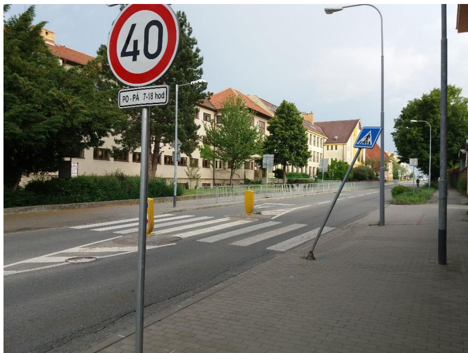
Obrázek 1: nakloněná dopravní značka označující přechod pro chodce na Holzové (u křižovatky s ulicí Karolíny Světlé)
