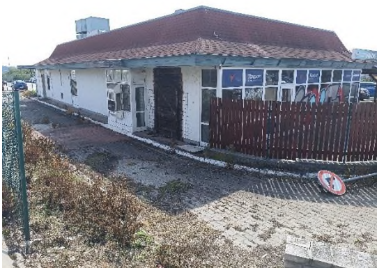
Obrázek 19: kontrola objektu býv. mc. Donaldu
