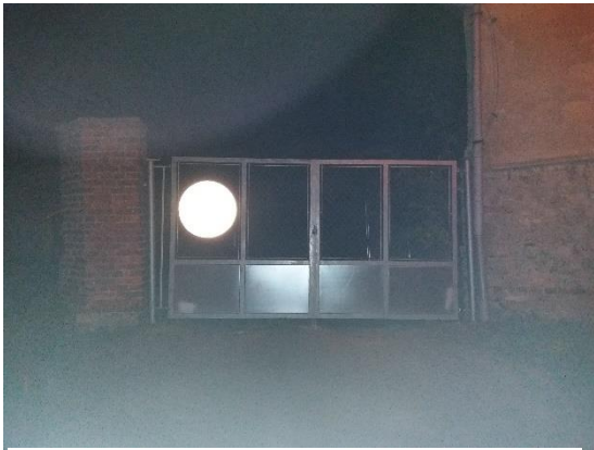
Obrázek 4: kontrola brány objektu ÚMČ na Holzové 7
