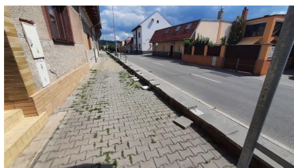
Obrázek 19: Uvolněné dlaždice před domy Šimáčkova 19 a 21
