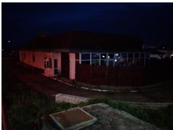
Obrázek 12: kontrola objektu bývalého Mc Donaldu
