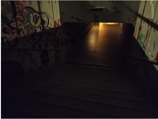
Obrázek 1: kontrola podchodu pod ulicí Jedovnická
