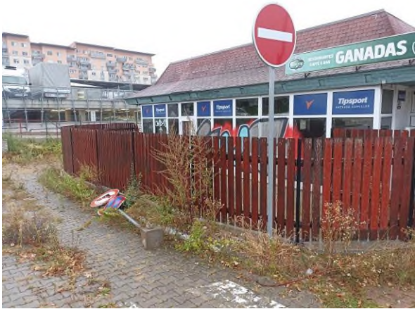
Obrázek 17: vyvrácená dopravní značka vedle objektu bývalého mc. Donaldu
