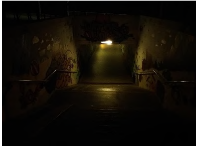
Obrázek 15 – kontrola pochodu pod ulicí Novolíšeňskou
