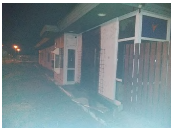
Obrázek 6 – kontrola objektu bývalého Mc Donaldu
