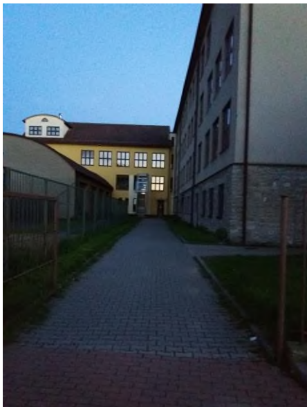
Obrázek 12: kontrola objektu ZŠ Holzova
