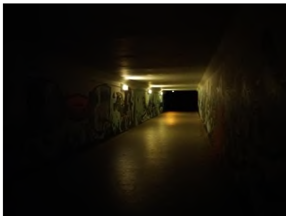
Obrázek 4: kontrola podchodu pod Novolíšeňskou
