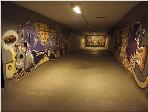
Obrázek 1: kontrola podchodu mezi Horníkovou a Rovnoběžnou
