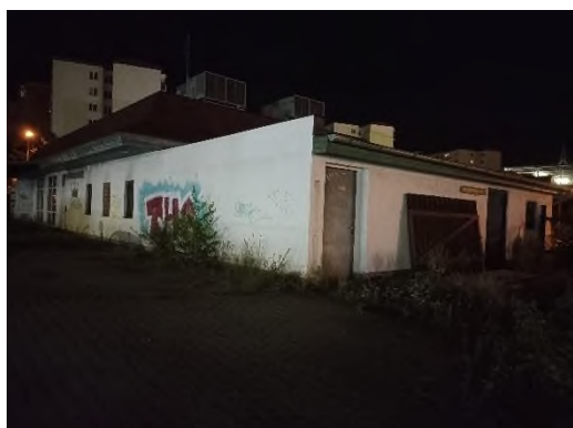
Obrázek 12: kontrola objektu bývalého mc. Donaldu
