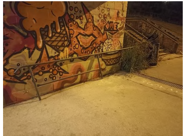
Obrázky 7 a 8: poškozené schodiště při východu z podchodu pod zastávkami MHD Novolíšeňská (na straně směrem k Trnkové). Jsou zde vyložené a rozbité dlaždice, vyvrácené zábradlí a přerostlá zeleň.
