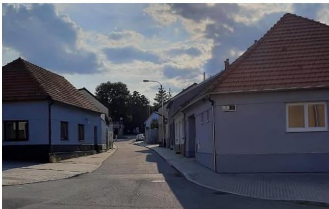
Obrázek 9: Na rohu náměstí Karla IV. č. 1 a Trnkova č. 2 chybí dopravní značka označující jednosměrku
