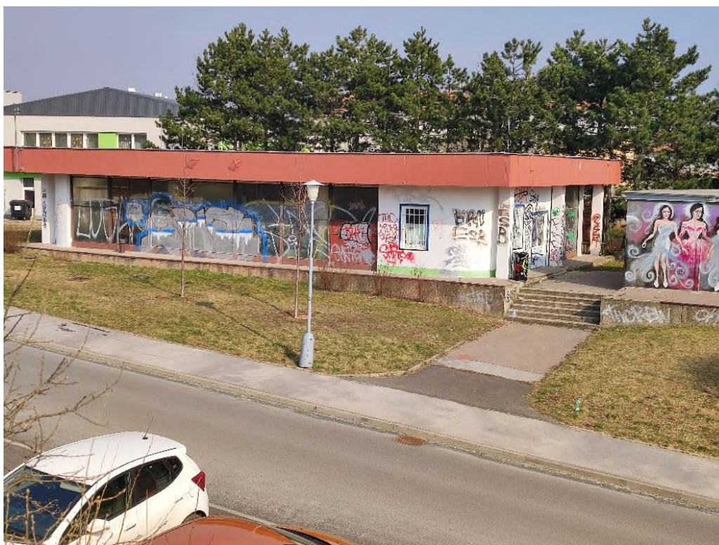
Foto 9: Sprejerství na objektu budovy a trafostanici na ul. Puchýřova
