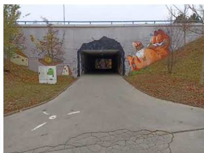
foto 19: kontrola podchodu pod Novolišeňskou
