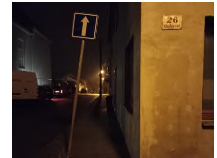
foto 9: nakloněná dopravní značka na Klajdovské 26
