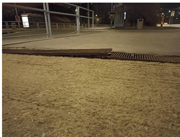
Obrázek 3 a 4: vedle tram zast. Novolíšeňská je u vstupu do podchodu ohnutá a vystouplá mříž, pro chodce riziko zakopnutí..
