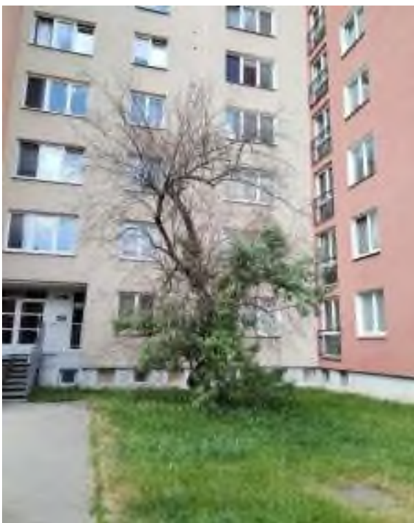
Hlošina č. 1 celkový pohled
