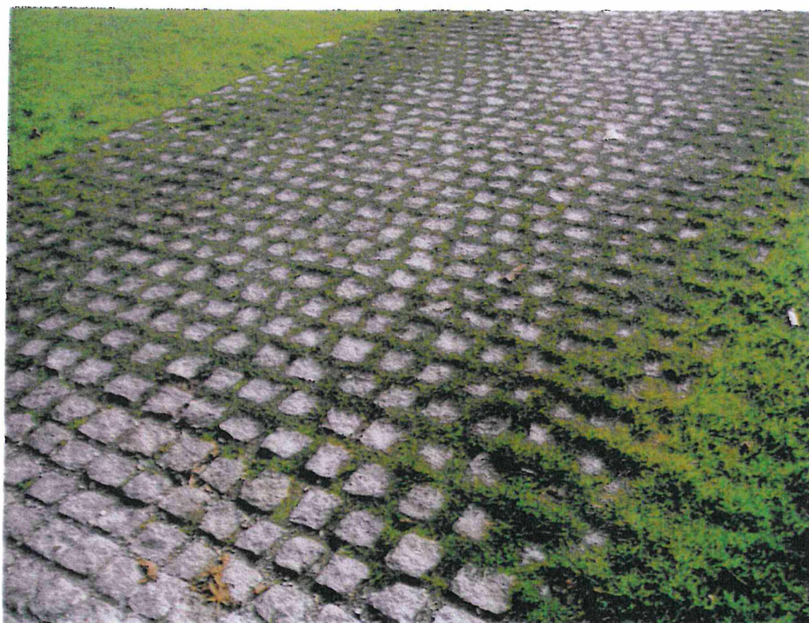
Zpevněná nájezdová rampa / žulová kostka v travnaté spáře
