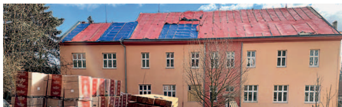
Výměna střechy na budově Šimáčkova 1
