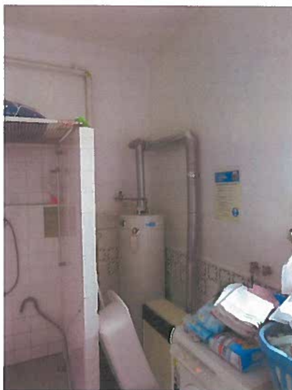
Obr. 110 Jiný pohled v místnosti 13.
