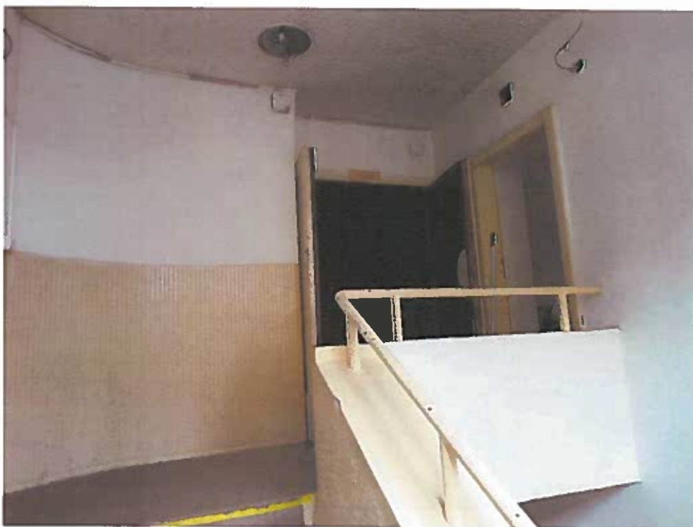
Obr. 56 Výstupní podesta schodiště ve 2NP Orlovny.
