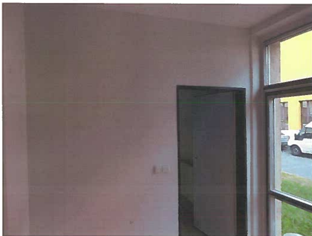
Obr. 21 Vstupní zádveří vedlejší č. m. 106.
