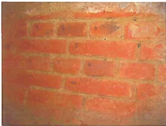
Foto 11 Pohled na sondu Z6 pro stanovení pevnostních parametrů zdiva (zdící prvky + malta)
