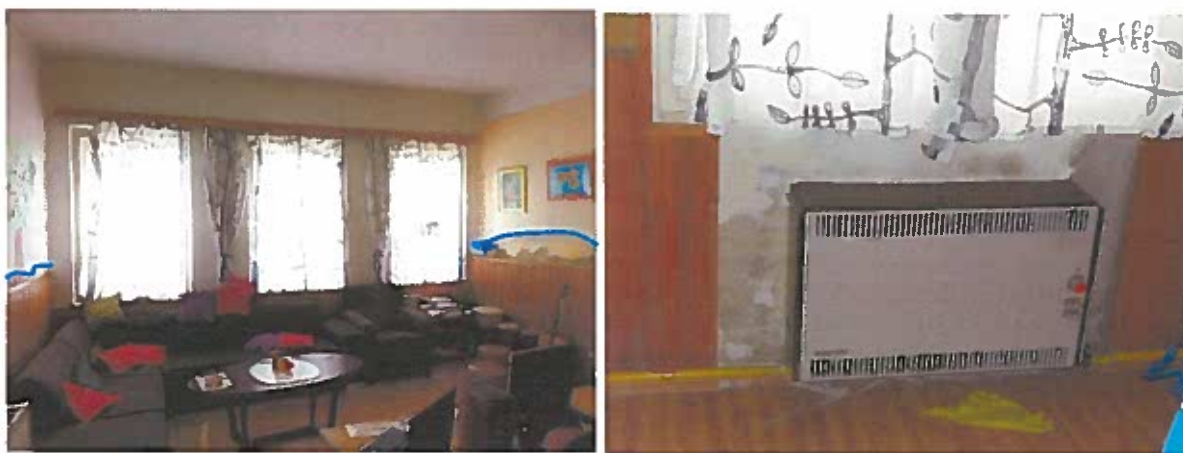
Obr. 25 Vlhkostní mapy zjištěné v místnosti 11 Effeta
