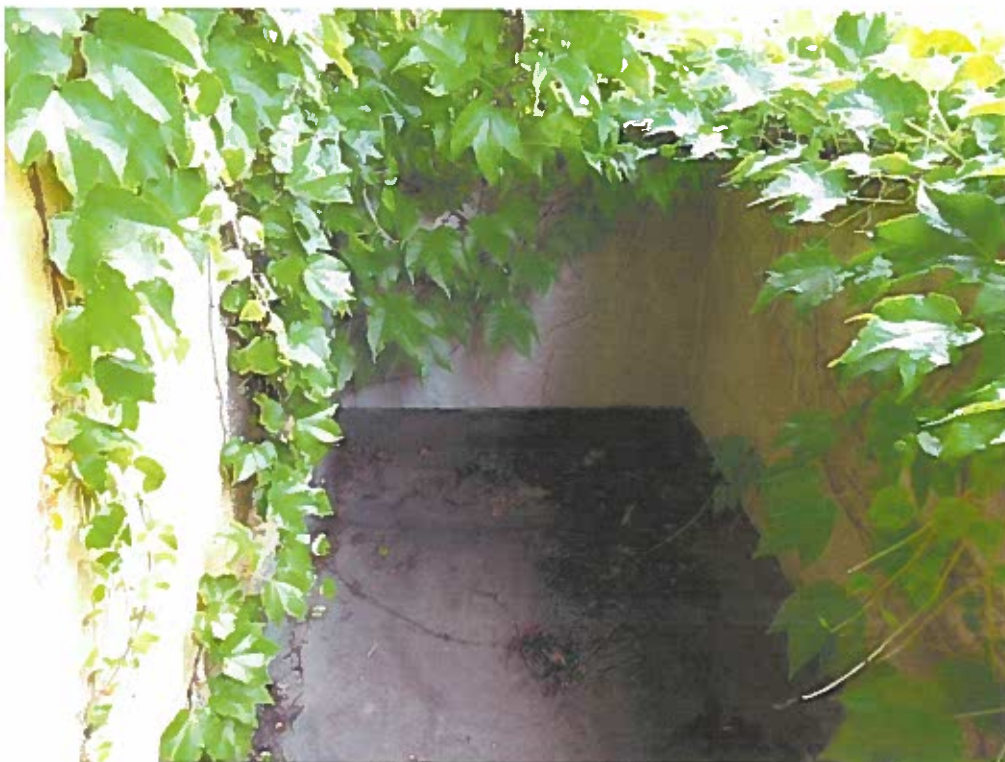
Obr. 117 Pohled na balkón č. 200, 2NP Effeta.
