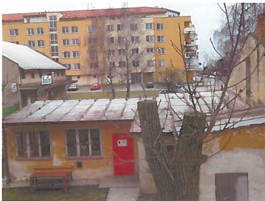
Obr. 77 pohled na pultové střechy přístavků z plechové falcované krytiny.
