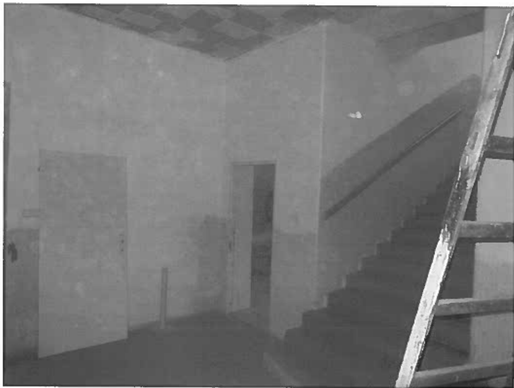
Obr. 30 Vstupní hala, výstupní schodiště vchod do klubovny.
