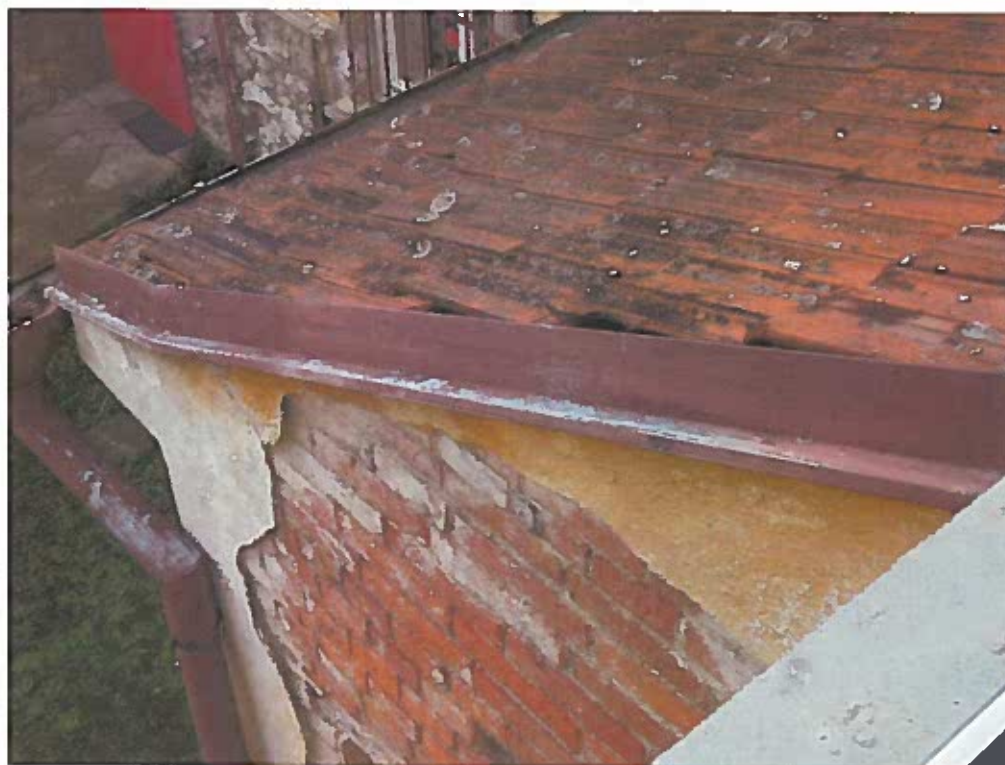
Obr. 76 Detaily poršení střešních tašek a fasáda nad spiží 06.
