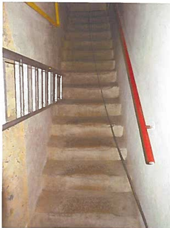
Obr. 81 Betonové schody do sklepa Effeta.
