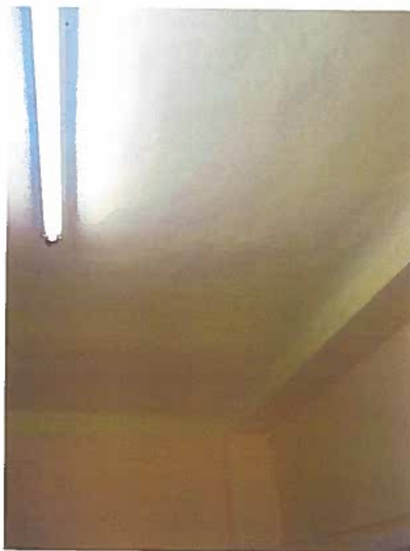
Obr. 98 Nerovný pohled stropu v místnosti 08.
