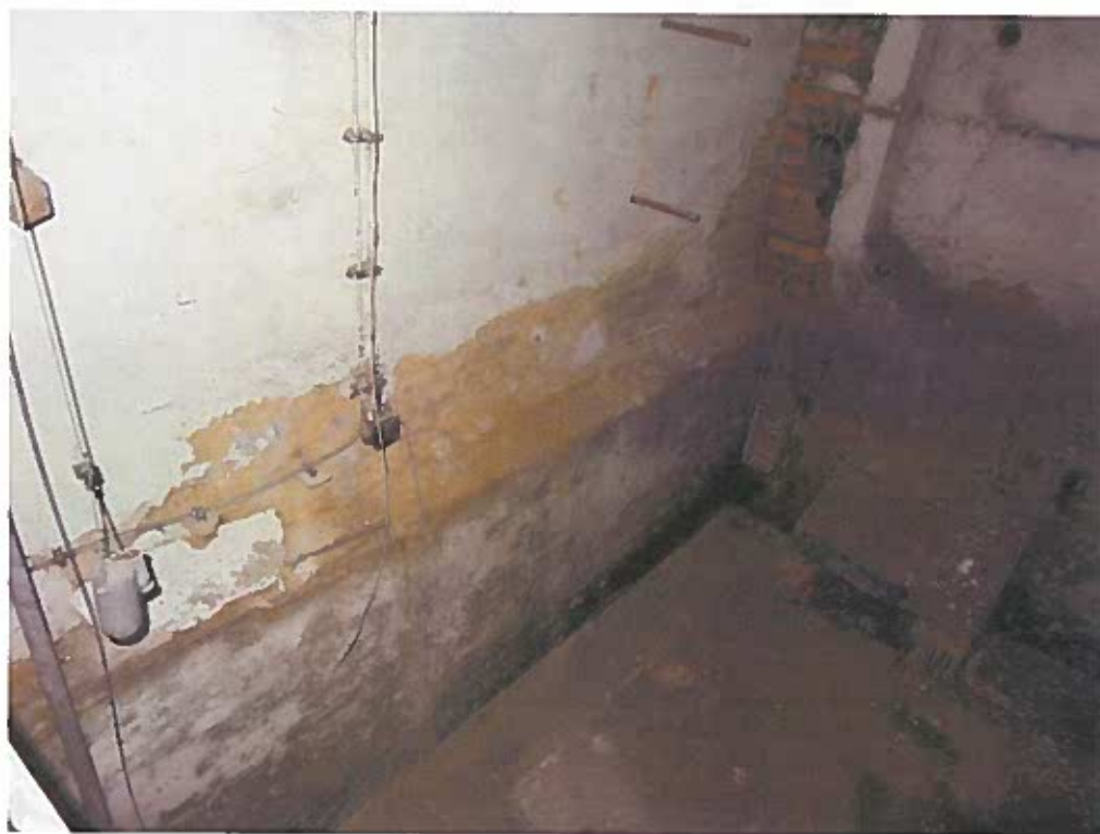
Obr. 52 Pohled do místa bývalého kotle ve sklepě Orlovny.
