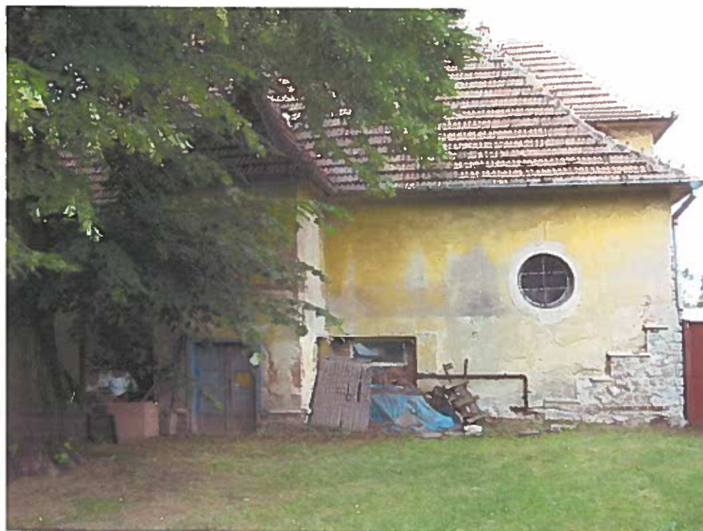
Obr. 17 Pohled na část Orlovny ze Dvora.
