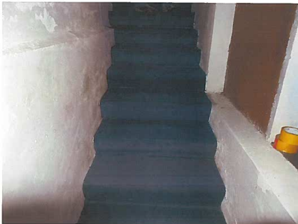
Obr. 53 Schody do sklepa místnost 112 (k posilovně).
