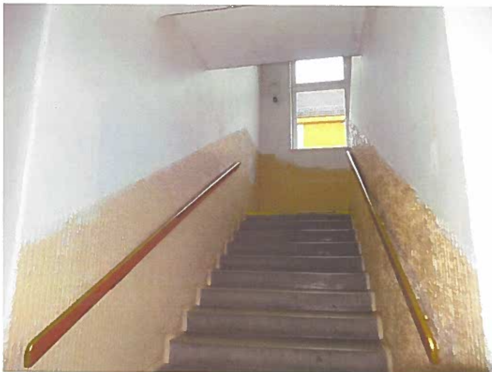
Obr. 55 Schody do 2NP, pohled z místnosti 102.
