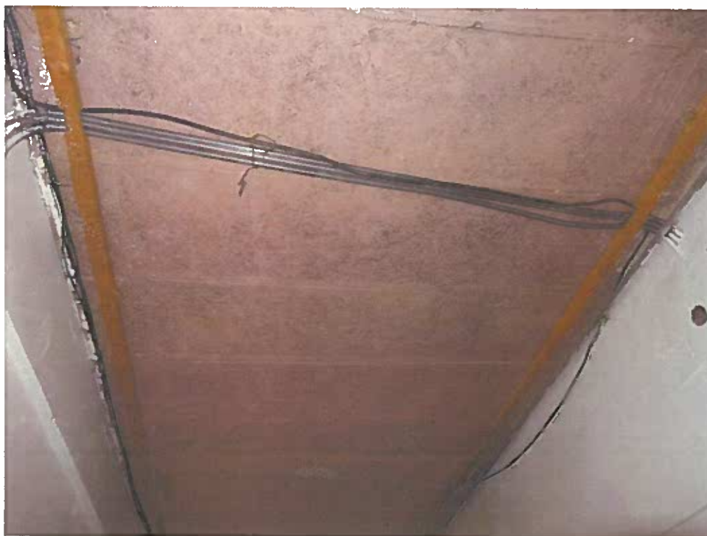
Obr. 38 Heraklitový pohled chodby č. 118.
