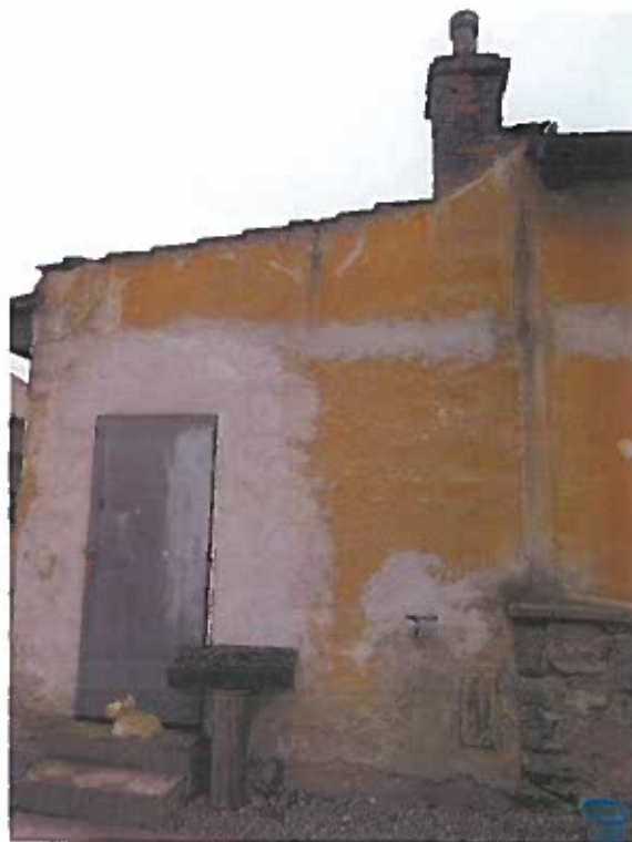
Obr. 16 Pohled na spiž ze dvora (degradace fasád).
