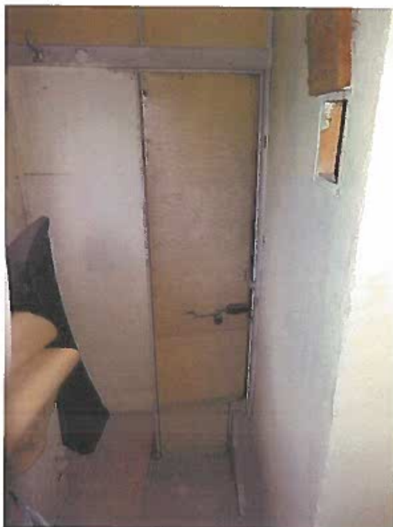
Obr. 47 Pohled na sololitové dveře na schody místnosti 112.
