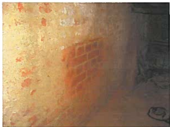
Foto 12 Detail na připravené zkušební místo Z6 s označenými zdíci prvky, na kterých byly provedeny NDT pevnostní zkoušky zdiva
