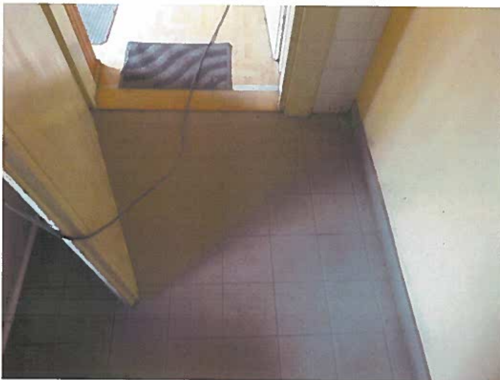
Obr. 93 Podlaha a vstupní dveře do kuchyně 05 - Effeta.
