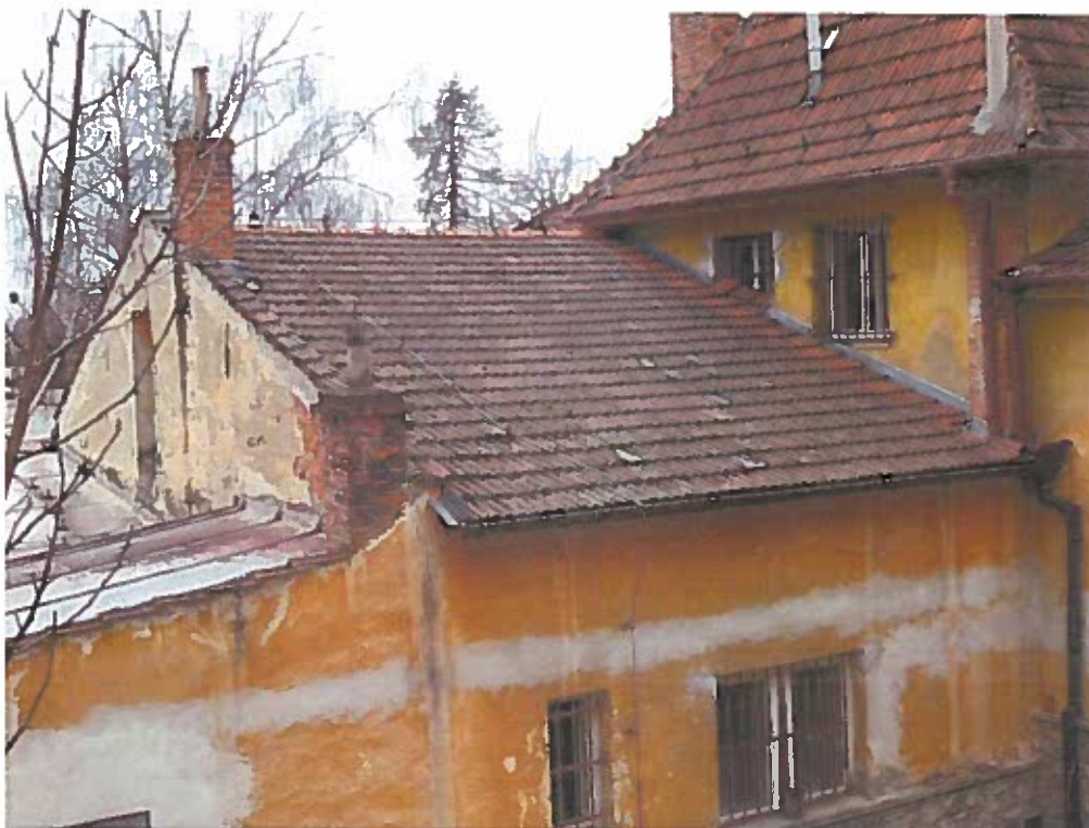
Obr. 75 Nízká sedlová střecha na na části budovy Effeta.
