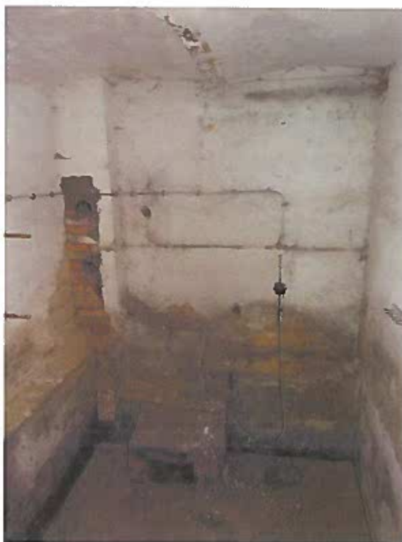
Obr. 51 Místnost bývalé kotelny ve sklepě, dnešní sklad.
