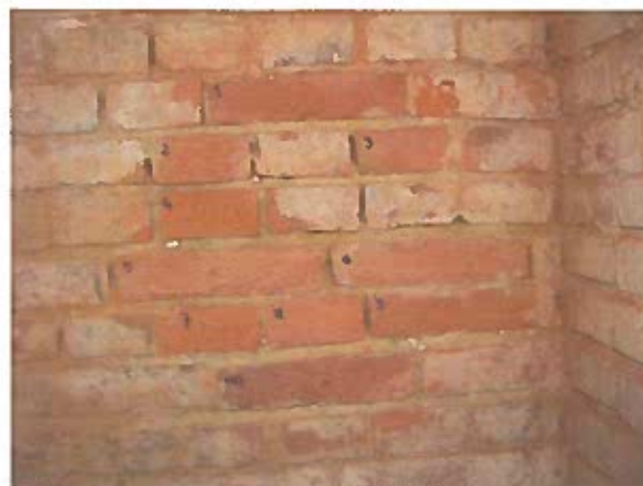
Foto 2 Detail na připravené zkušební místo Z1 s označenými zdicími prvky, na kterých byly provedeny NDT pevnostní zkoušky zdiva
