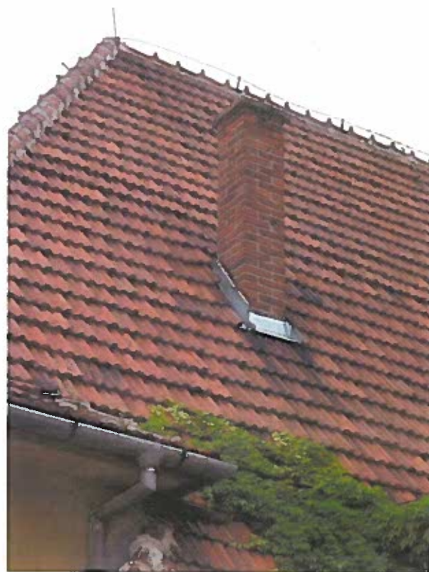
Obr. 71 Pohled na střechu z exteriéru, komín nad jižní částí Effeta.
