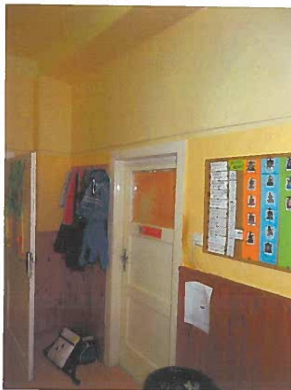
Obr. 97 Pohled na dveře šatny klientů z místnosti č. 08.
