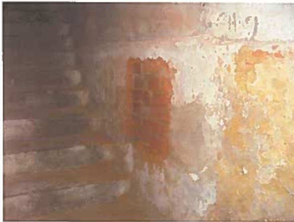
Foto 7 Pohled na sondu Z4 pro stanovení pevnostních parametrů zdiva (zdící prvky + malta)
