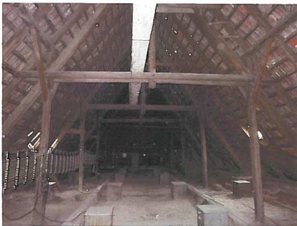
Obr. 66 Krový části objektu Orlovna.
