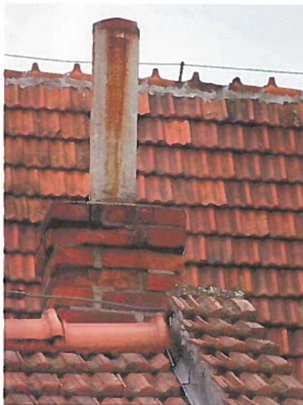
Obr. 79 Porušená hlava komínu u nízké sedlové střechy Effety.
