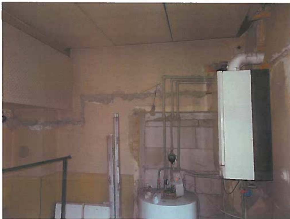
Obr. 45 Místnost skladu č. 108 a ohříváče vody.
