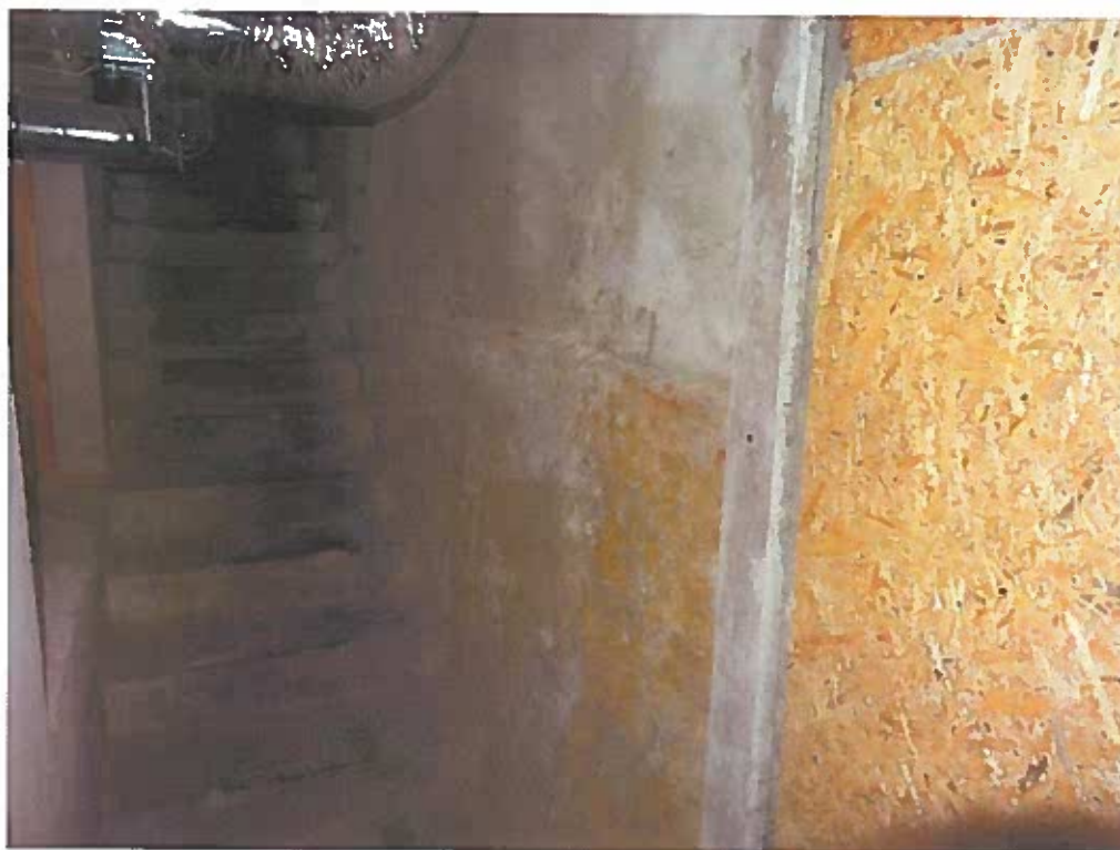
Obr. 48 Schody do sklepa, m.č. 112.
