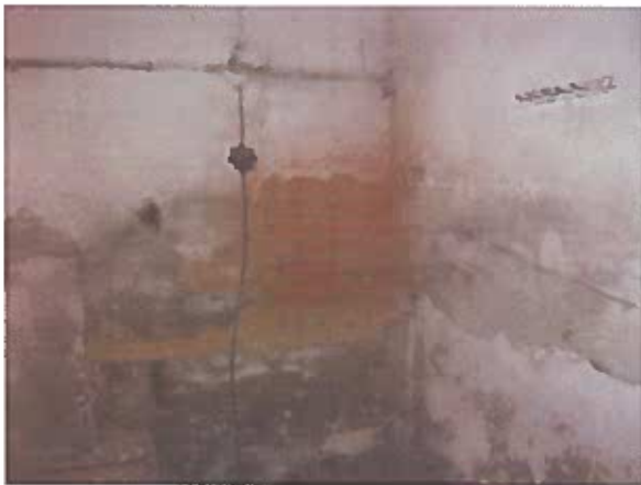
Foto 9 Pohled na sondu Z5 pro stanovení pevnostních parametrů zdiva (zdicí prvky + malta)
