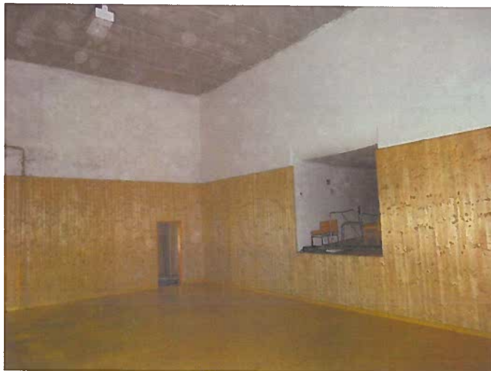
Obr. 41 Pohled do místnosti tělocvičny č. 111 (bývalé jeviště).
