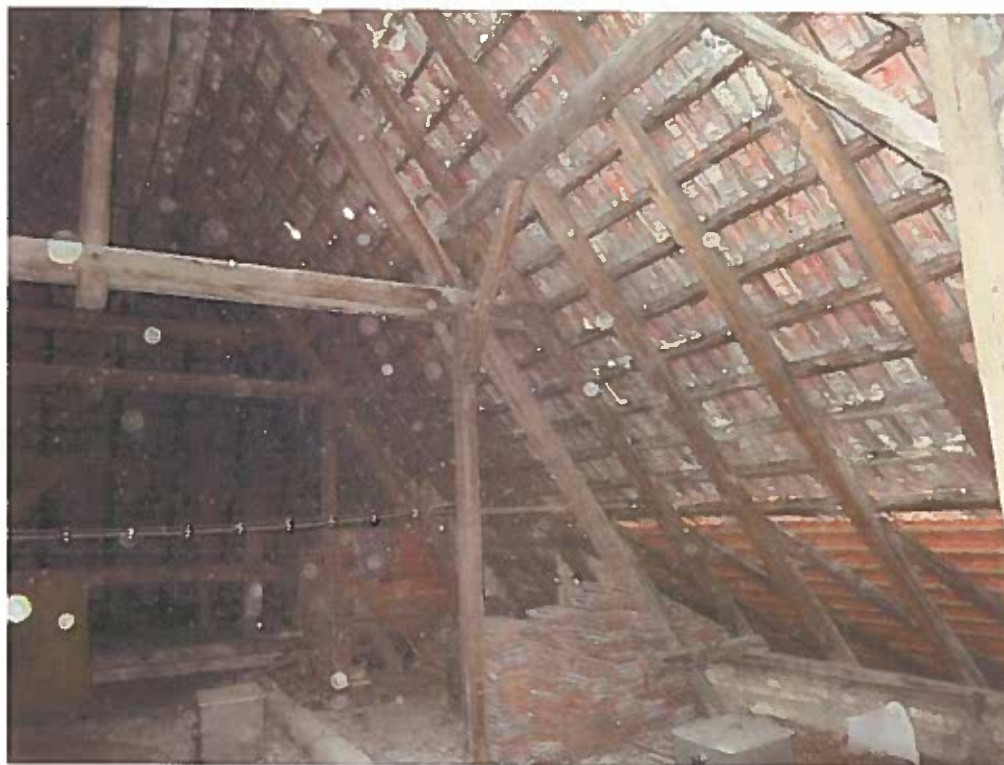
Obr. 67 Pohled na krovy nad částí Orlovny.
