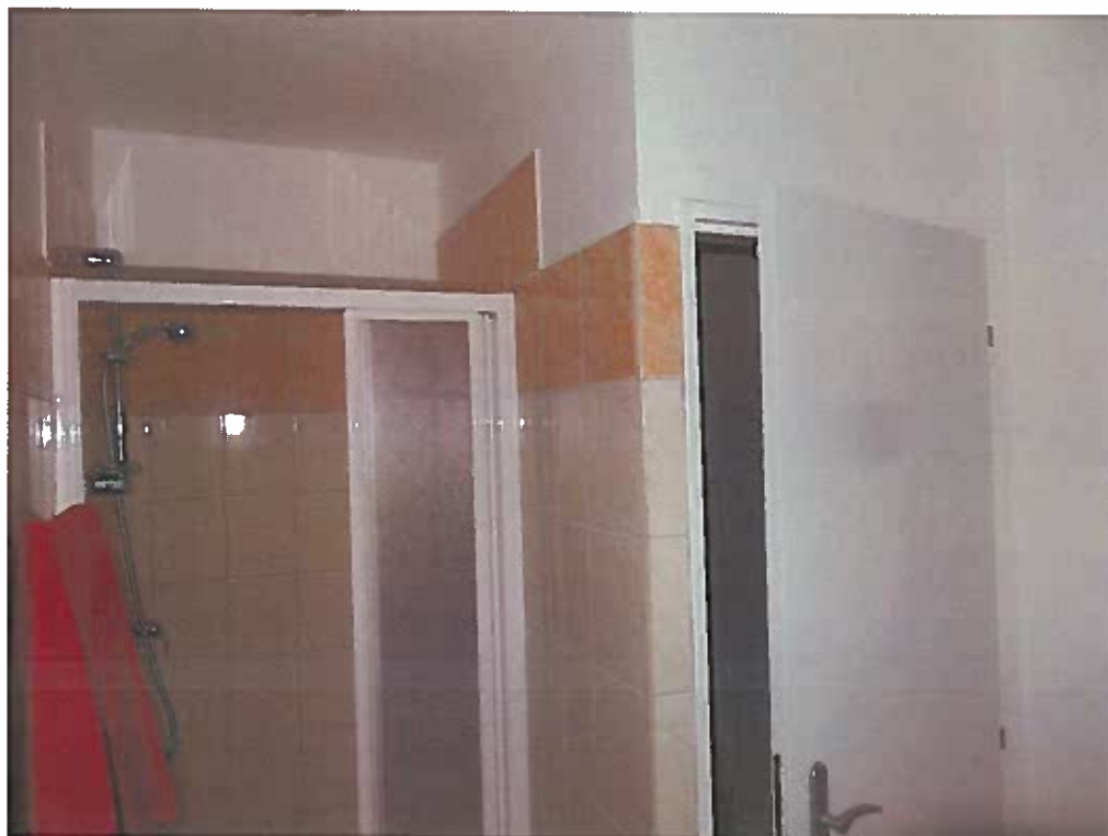
Obr. 59 Místnost sociálních zařízení č. 208 v části Orlovna.
