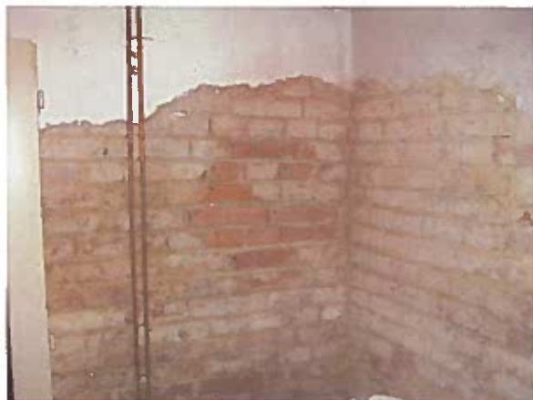
Foto 1 Pohled na sondu Z1 pro stanovení pevnostních parametrů zdiva (zdicí prvky + malta)
