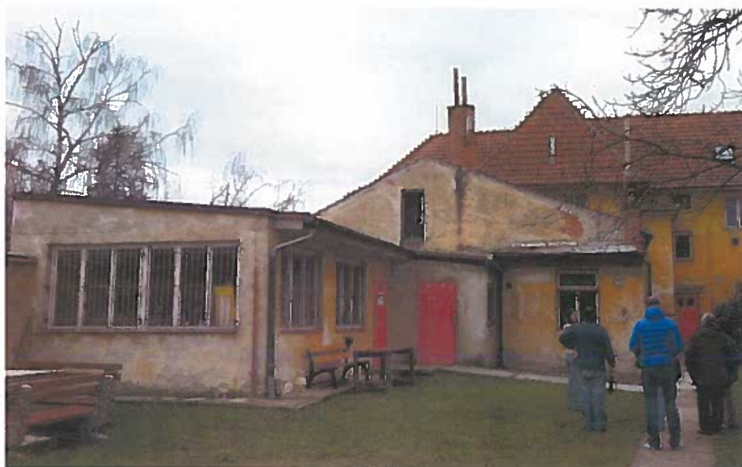
Obr. 14 Pohled na přístavky k části Effeta.
