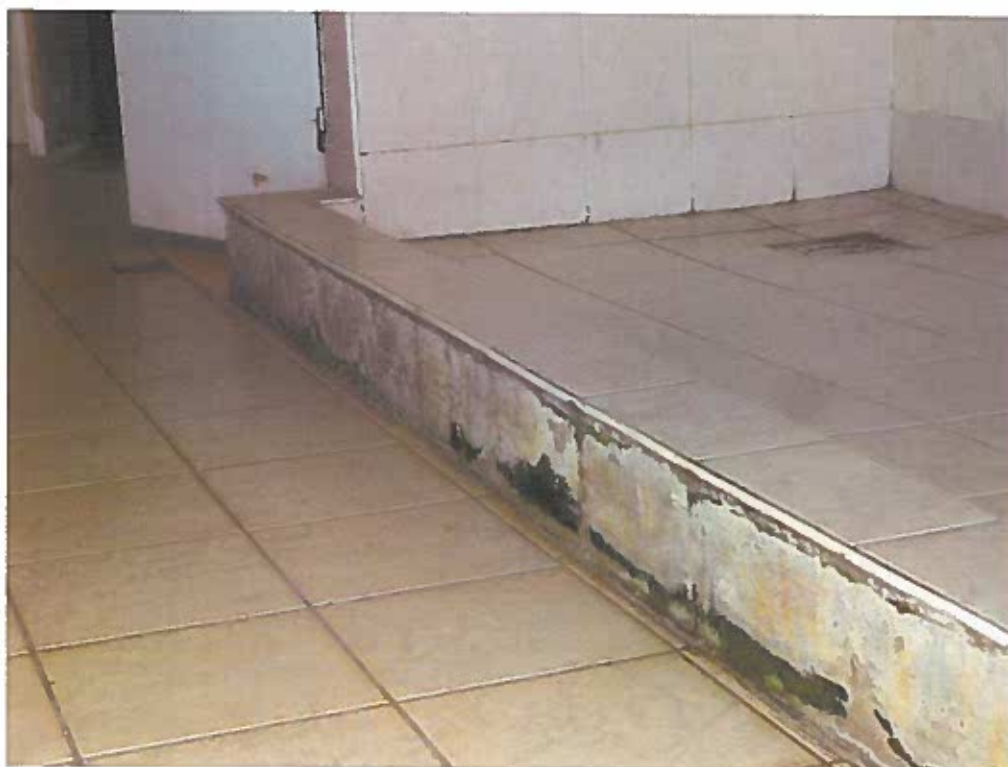
Obr. 24 Sociální zařízení k šatnám hostí, m.č. 105, opadavý obklad soklíku sprchy.
