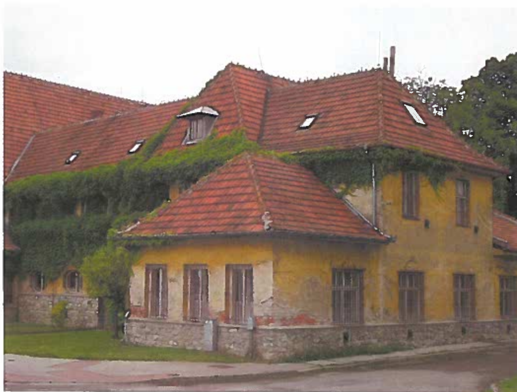
Obr. 9 Roh objektu Effety, ulice Holzova a Leskauerova.
