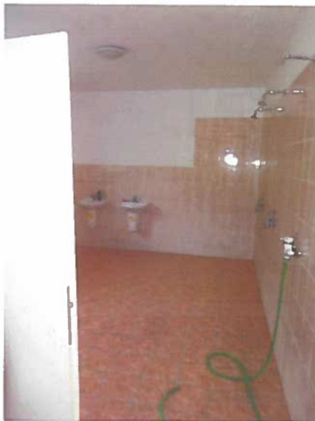
Obr. 63 Pohled místnosti sociálních zařízení č. 205.
