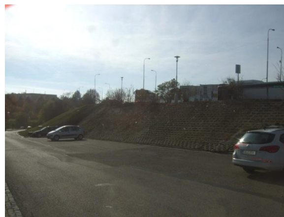
Nevhodně řešené zpevnění svahu
