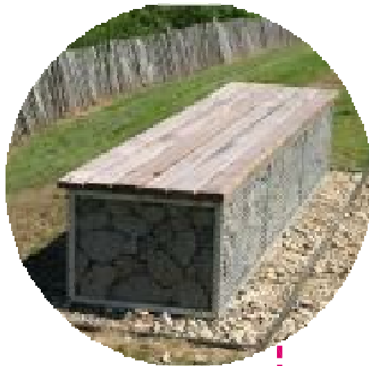
mobiliář z gabionů
