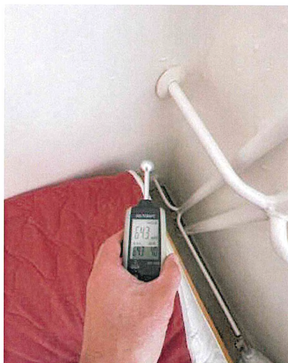
Spodní úroveň - Vlhkost 11%
