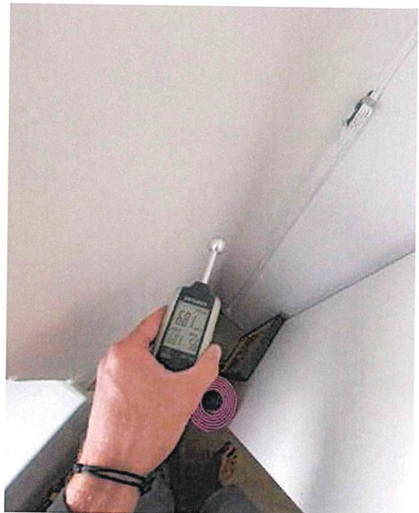
Spodní úroveň - Vlhkost 12%
