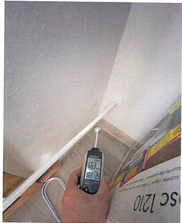
Spodní úroveň - Vlhkost 11%
