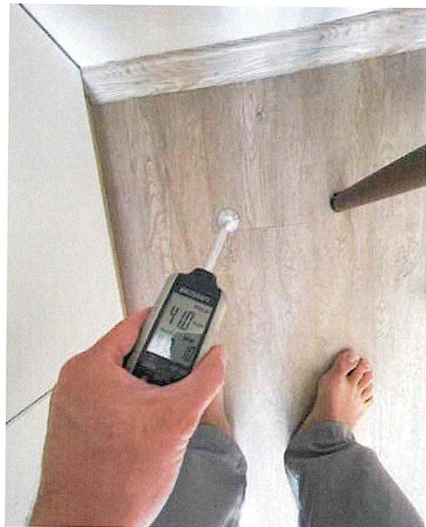
Spodní úroveň - Vlhkost 4%
