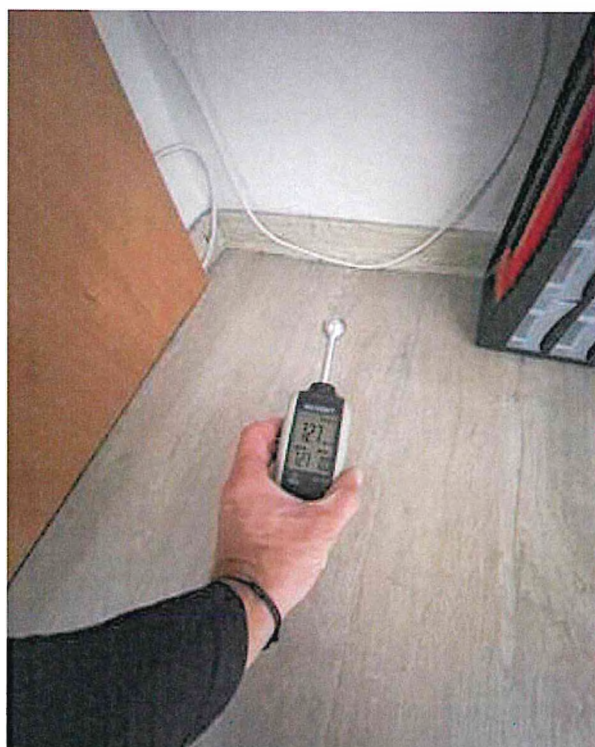
Spodní úroveň - Vlhkost 13%
