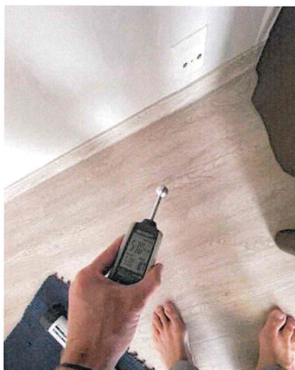
Spodní úroveň - Vlhkost 7%
