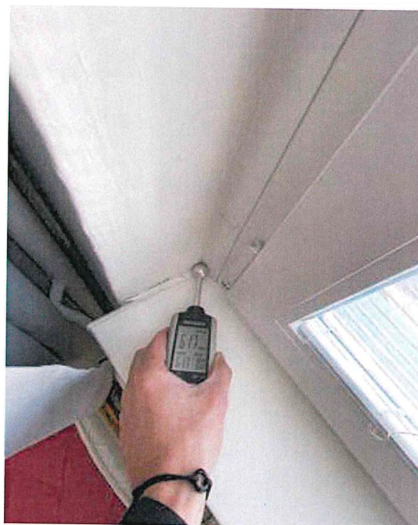
Spodní úroveň - Vlhkost 10%
