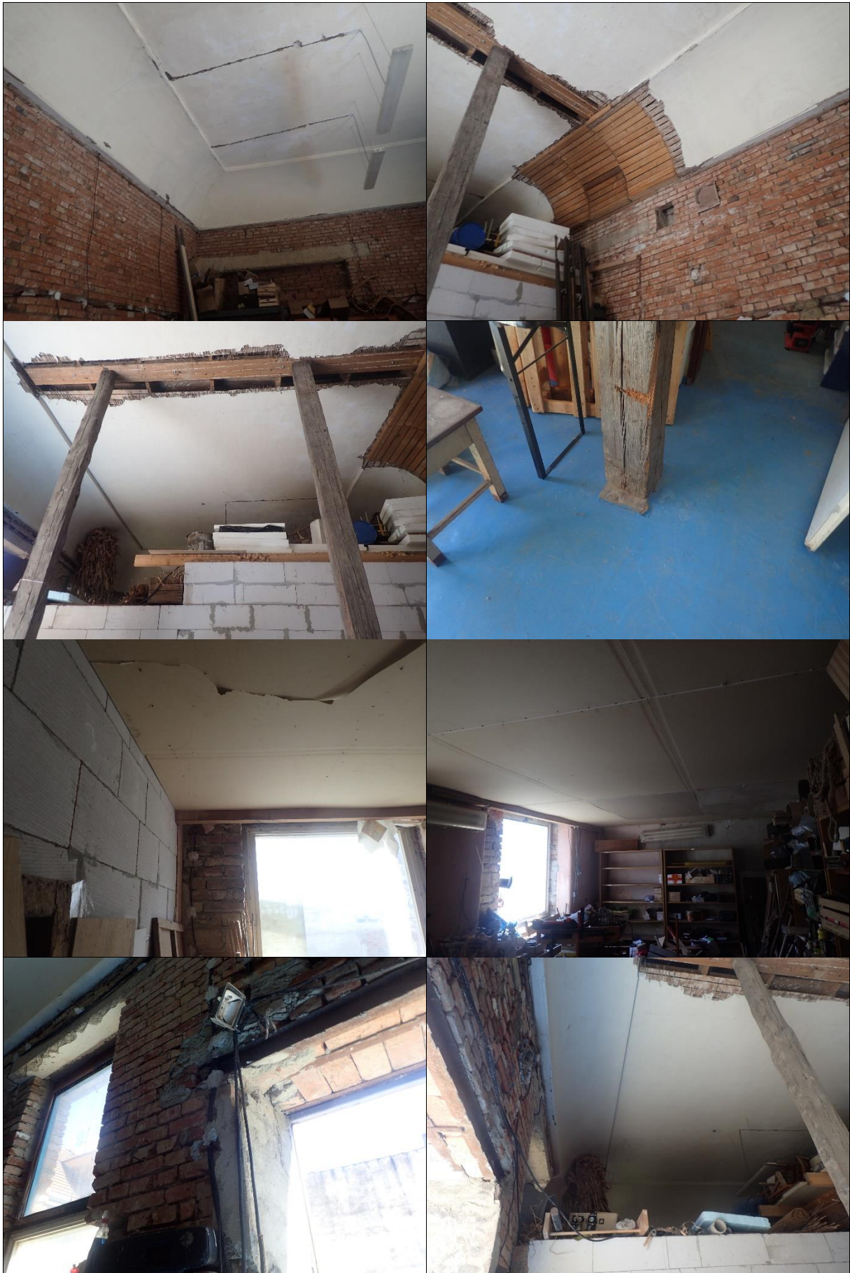
Dvorní trakt interiér:
