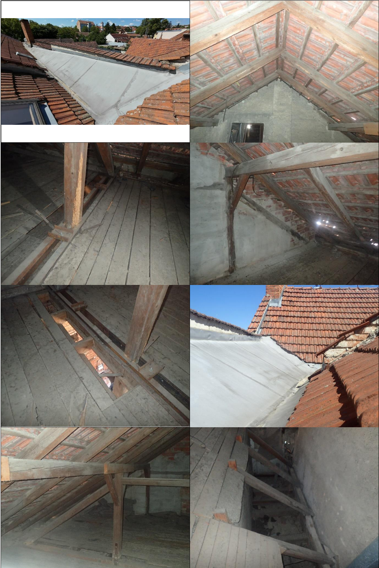
Krov a střecha nad prostorem sálu:
