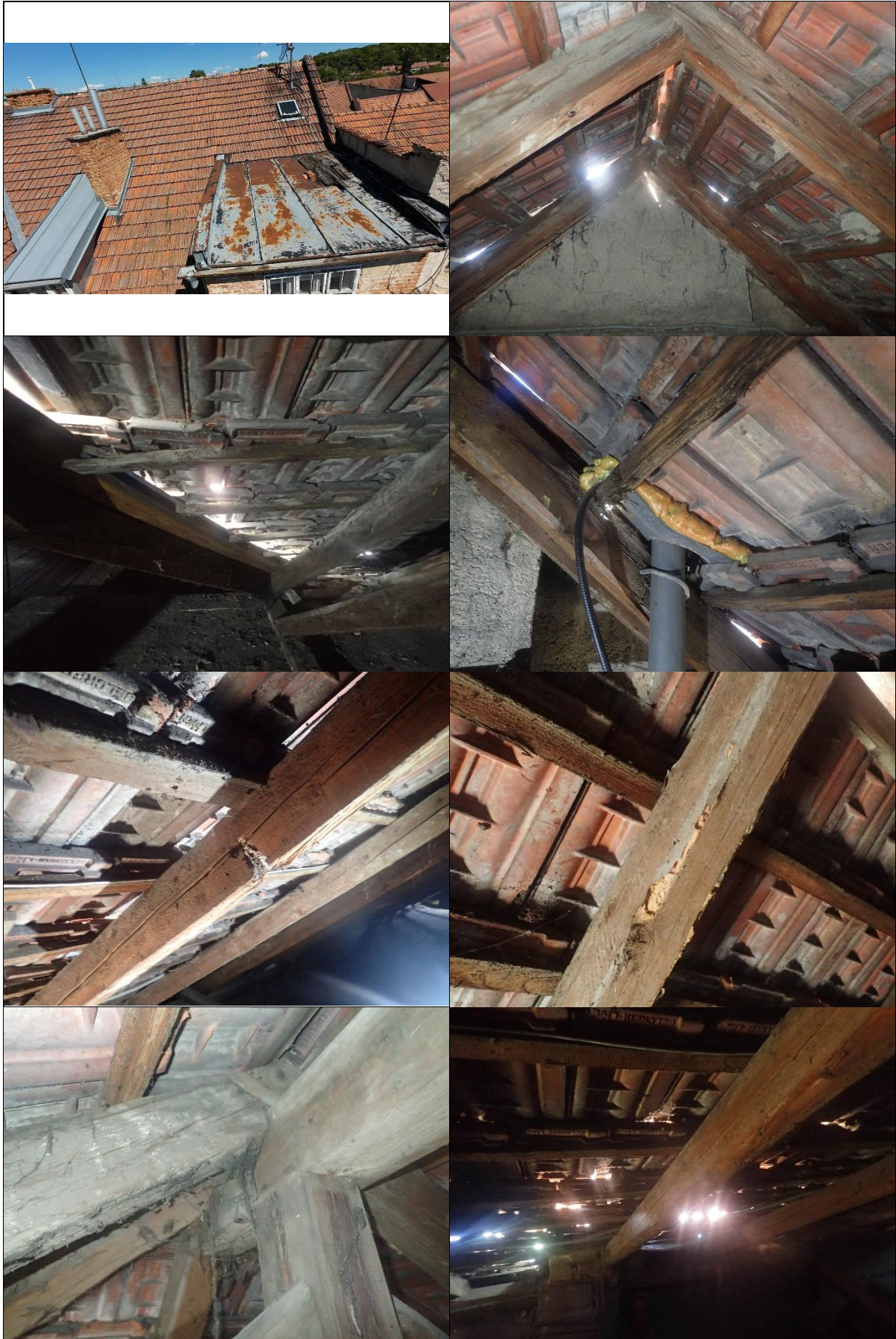
Krov a střecha nad hlavní budovou:
